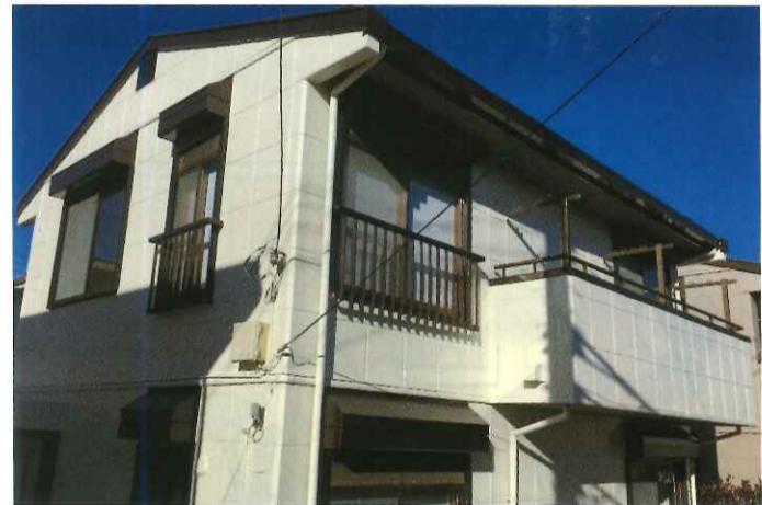
塗り替えで外観がきれいになるのはもちろん、耐久性もアップする 写真提供/AGCコーテック
