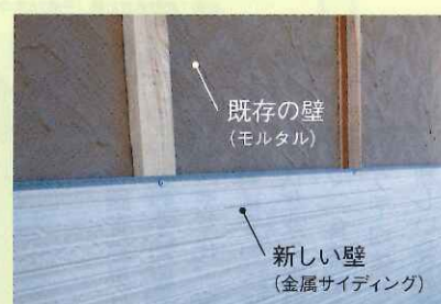
既存の壁に木材を取り付け、その上に新しい壁を重ねる 写真提供/アイジー工業
